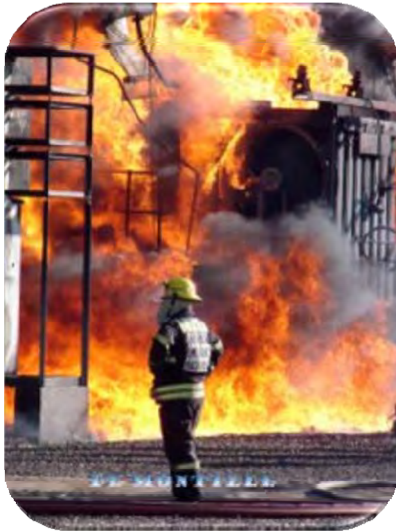
Subestação em Boksburg – África do Sul
