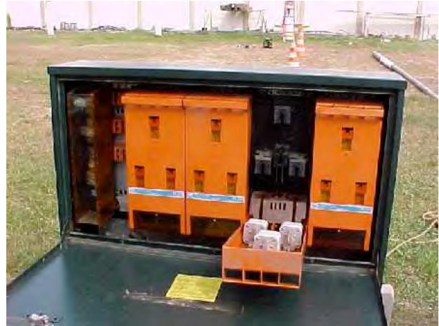
**Chave Comutadora de Baixa Tensão, fotos de uma chave seccionadora de BT de outro fabricante que também pode ser utilizada/configurada para a atividade.**
