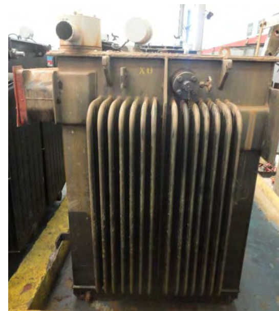
Transformador retirado da CT-202
