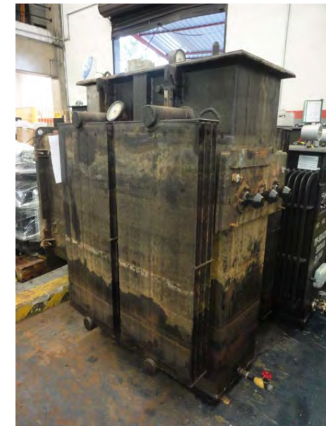
Transformador retirado da CT-1031
