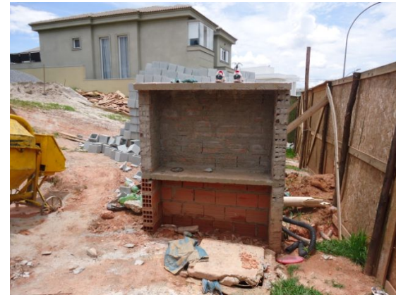
Entrada de energia em início de construção
